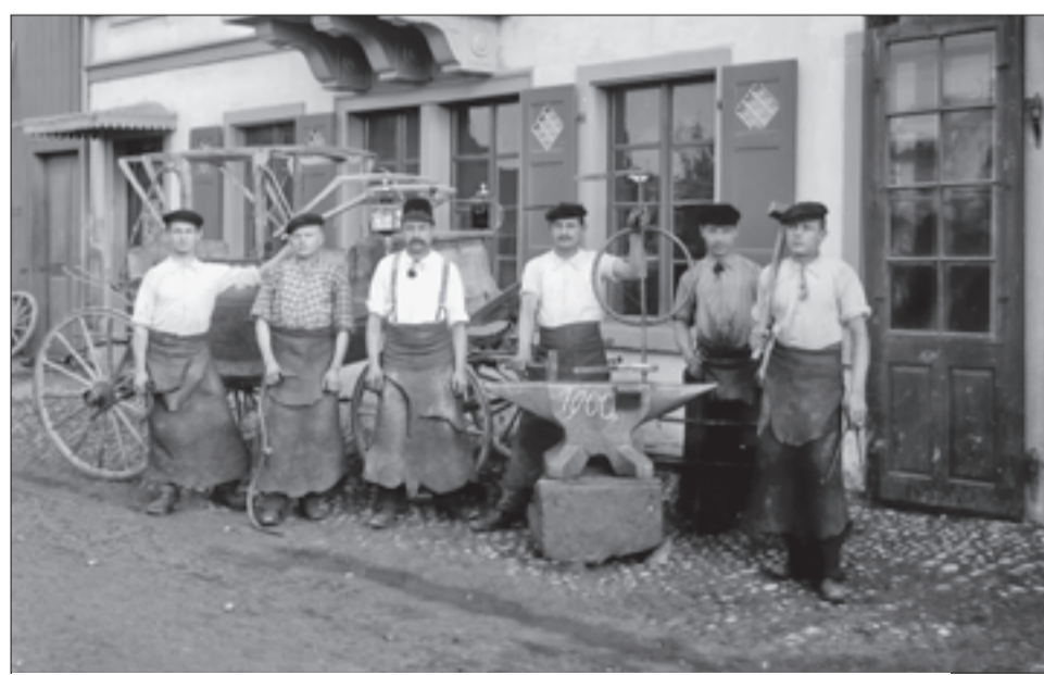
GUTE ALTE ZEIT. Die Schmiede Lanker, 1900 vom Fotografen Bär aufgenommen. Damals an der Eisenbahnstrasse 277, heute Bahnhofstrasse auf Höhe der vormaligen «Migros».
