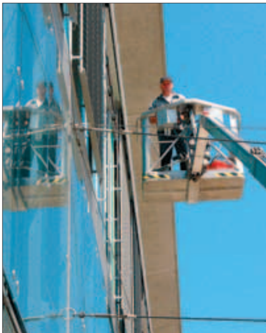
ERSTER EINDRUCK. Blitzblank spiegelnde Fassade beim Bahnhofplatz.
