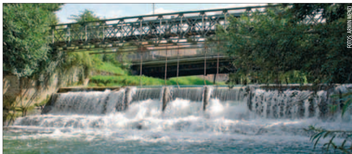
ÖKO-STROM. Das neue Wasserkraftwerk Zeughausbrücke wird Strom für 100 Haushalte erzeugen.
