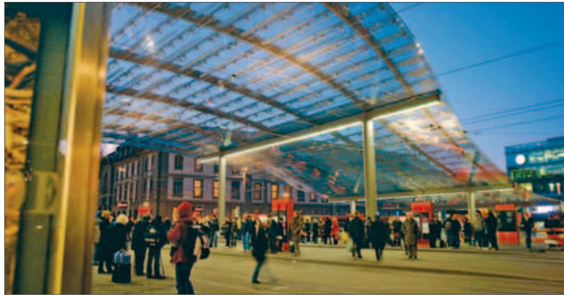
DACH ÜBER DEM KOPF. Die Frauenfelder Tuchs Schmid AG baute den „Baldachin“ beim Hauptbahnhof Bern.
