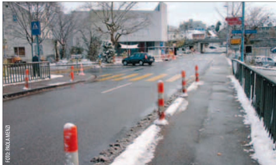
SANIERUNGSFALL. Zeughausbrücke und Kreislauf Zeughausstrasse–Militärstrasse.
