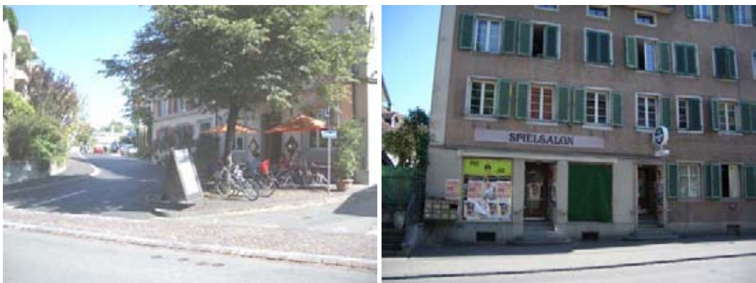
Abbildung 3: Lebendige Zürcherstrasse Ost mit teilweisen Verfallserscheinungen
