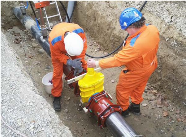
Montage eines zusätzlichen Schiebers in die 5-bar-Leitung «Badiwiese».
