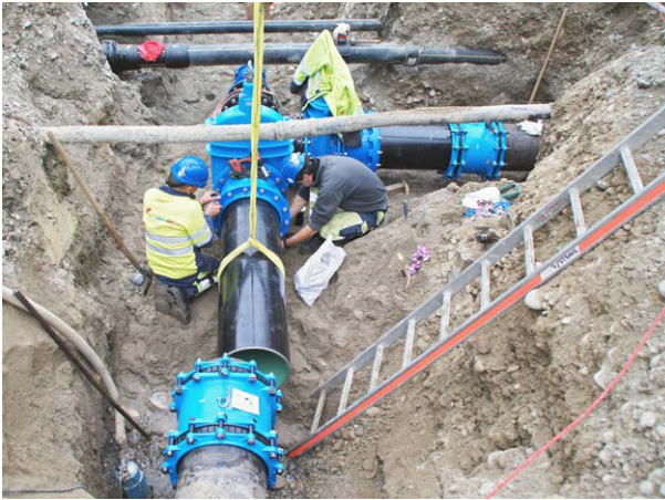
Ersatz eines T-Stücks DN 400mm mit Absperrungen an der Reutenenstrasse.
