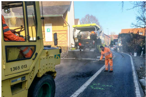
Belageinbau an der Hagenbuckerstrasse in Gerlikon.
