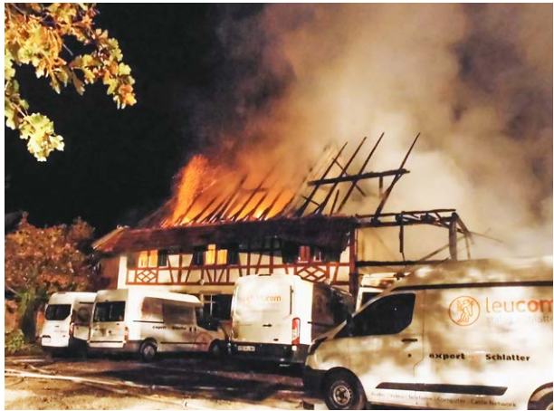
Beim Brand eines alten Bauernhauses mit angebauter Scheune an der Hungerbühlstrasse entstand am 17. Oktober hoher Sachschaden.
