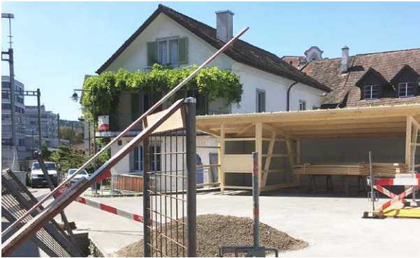
Bauarbeiten auf dem 20gi-Platz, der umgestaltet wird.
