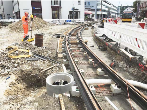
Sanierung von Gleisanlage sowie Ver- und Entsorgungsleitungen im Bereich Rathausplatz/Promenade.
