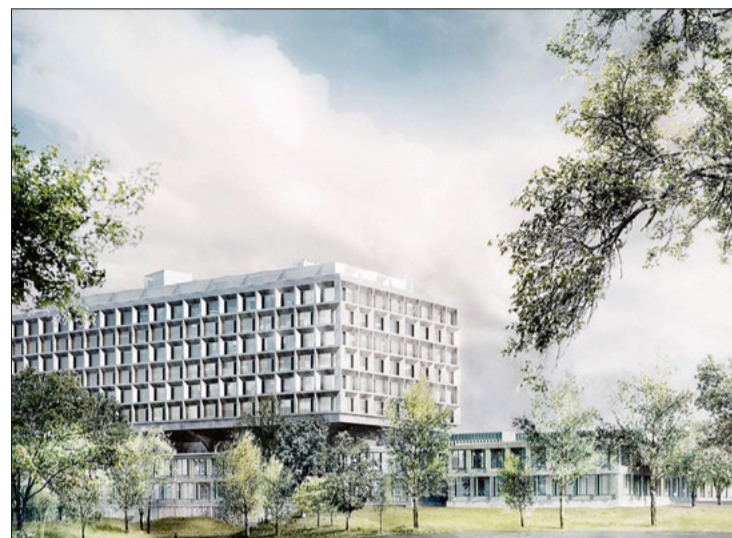
ÖKOENERGIE. Das neue Kantonsspital setzt auf die Nutzung von umweltfreundlicher Erdwärme. Zwei Erdwärmefelder dienen als Energiespeicher.
