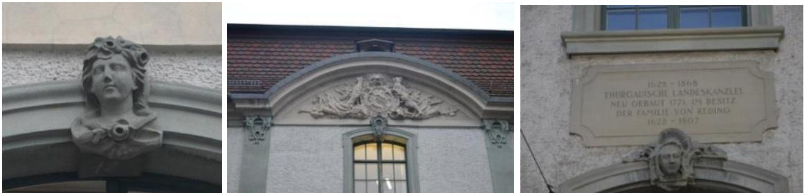
Abbildung 2: Sandsteinköpfe, Lisenen und Fenstergewände
