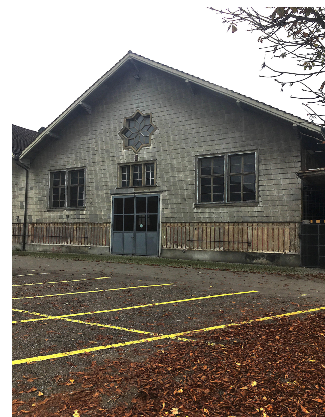
Ansicht Reithalle von Mätteli
