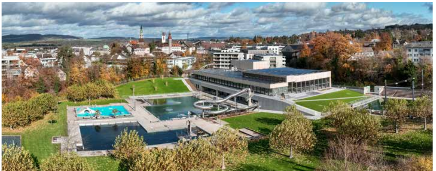
Die Schlossbadi umfasst den Neubau Hallenbad mit dem angrenzenden neuen Sprudelbad und das Frauenfelder Freibad.
