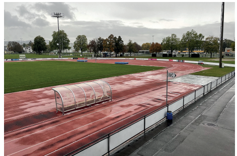
Abbildungen 2 und 3: Der Kunststoffbelag mit Flickstellen, Abnützungen und Wasserpfützen.
