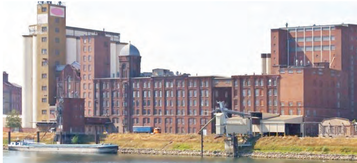
Industriebau, Mannheim, D
