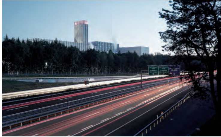
Energiezentrale Forsthaus West, Bern | Graber Pulver Architekten, 2008 - 2013
