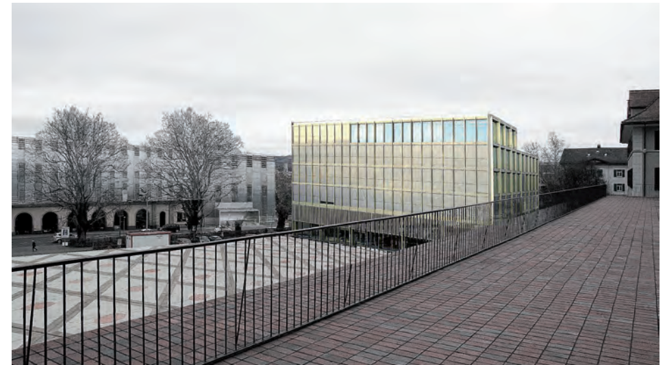
Neubau Kasernenplatz 5 Geschosse, Zeughaus Bahnhofstrasse (P&R) mit Aufstockung.
