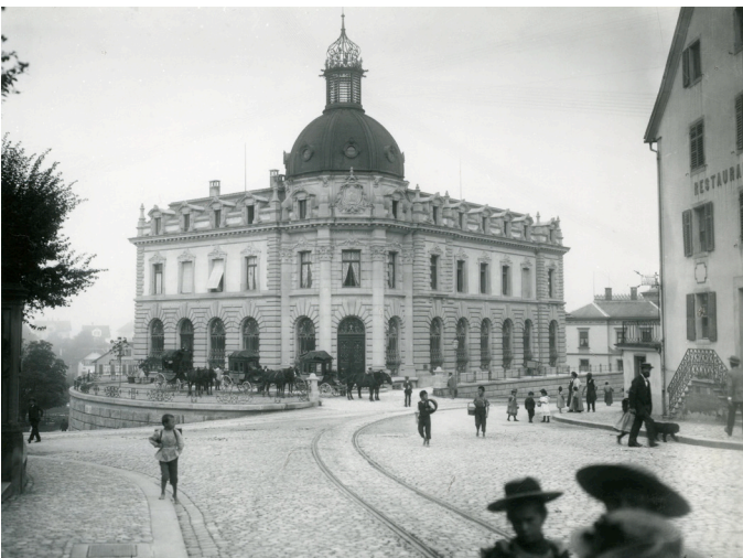
Postplatz um 1900, markantes, urbanes Stadthaus, Betonung der Ecksituation am Platz (Quelle: Stadt Frauenfeld)
