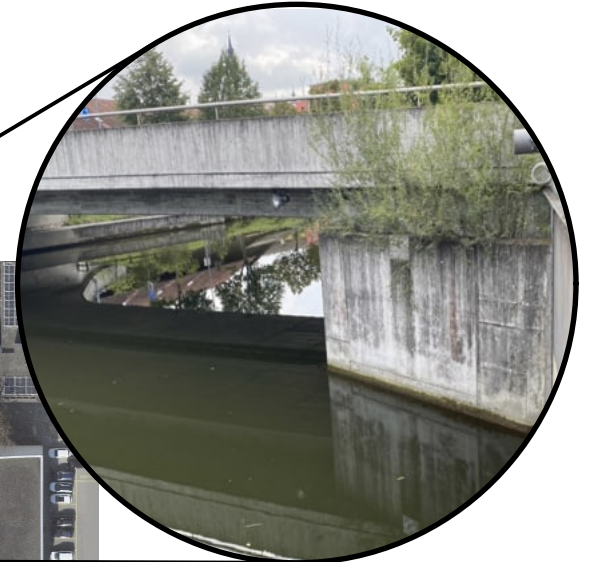
Brücke an der Zeughausstrasse
