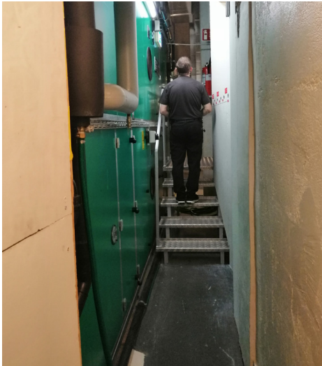
Abbildung 1: Zu schmaler Fluchtweg von der Galerie
