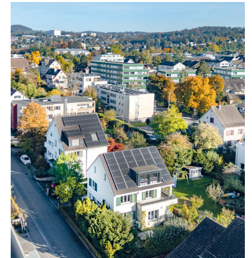
Abbildung 2: Projekte, die einen Beitrag zur Erfüllung der städtischen Energie- und Klimaziele leisten, sollen gefördert werden.
